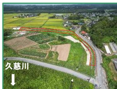
工事箇所の上流全景（下流から）
