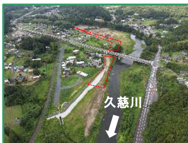
工事箇所の全景（下流から）
