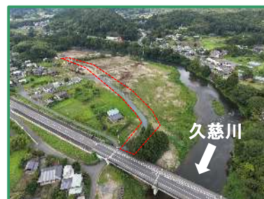
工事箇所の全景（上流から）
