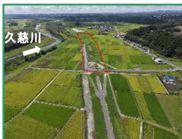
工事箇所の全景（上流から）
