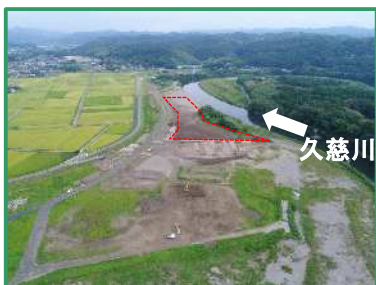
工事箇所の全景（上流から）
