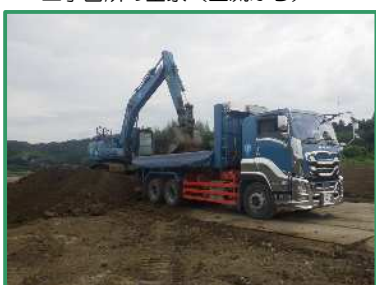
土砂の積み込み作業を行っています
