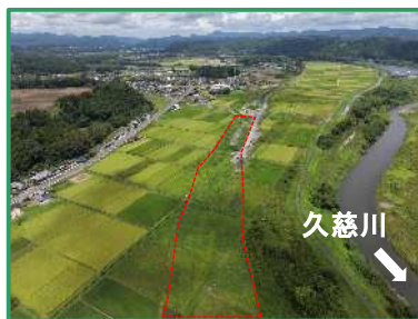
工事箇所の全景（下流から）
