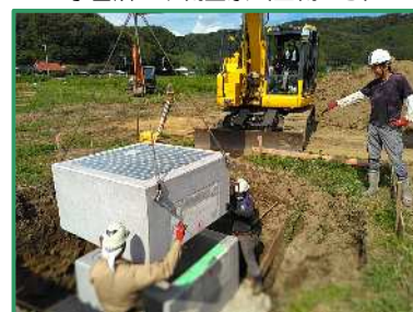
集水枡を設置しています
