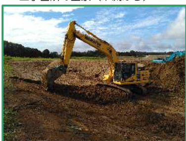
土砂の掘削作業を行っています
