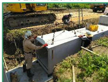
ボックスカルバートを設置しています
