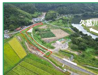
工事箇所の下流全景（上流から）
