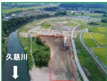
工事箇所の全景（下流から）
