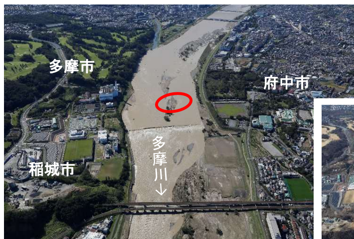
令和元年東日本台風の状況
