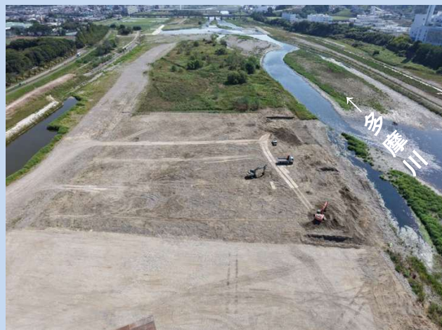
河道を掘削しています。 (令和8年8月)
