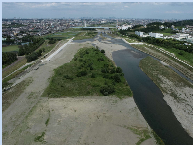
工事着手前 (令和8年6月)
