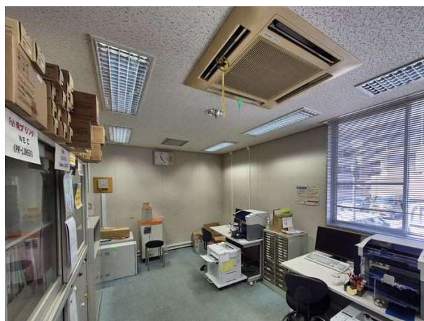
2F 電送機械室
