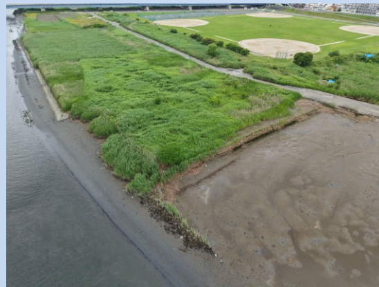
工事着手前 (令和8年6月)
