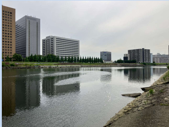
工事着手前です。 (令和8年6月)
