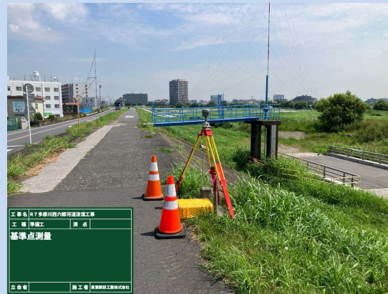
基準点測量と底質調査を行っています。 (令和8年7月)
