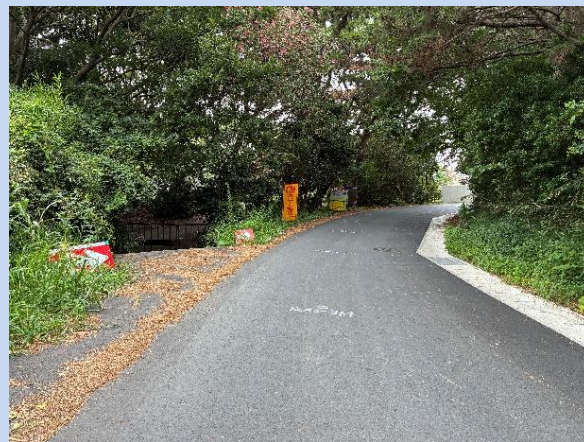
工事のための測量をしています。 (令和8年7月)
