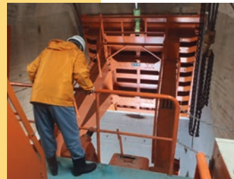
ゲートの点検 (コンジットゲート)
