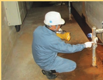
ダム堤体の点検 (堤体観測機器)
