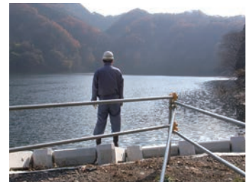
貯水池の点検 (湖面巡視)
