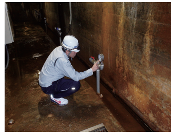
観測設備の点検 (堤体観測機器)
