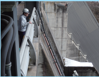
ダム堤体の点検 (外観点検)
