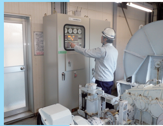
ゲートの点検 (クレストゲート)
