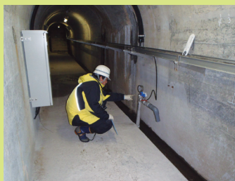
ダム堤体の点検 (堤体観測機器)
