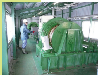
ゲートの点検 (クレストゲート)
