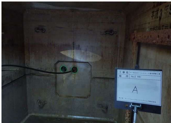
点検状況（ソフトバンクより）
