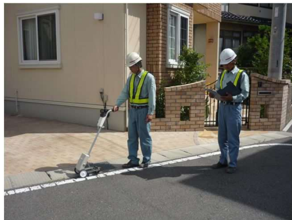
点検状況（松本ガスより）
