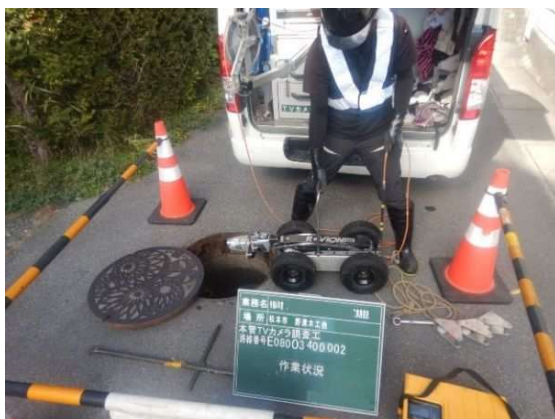
点検状況(松本市より)
