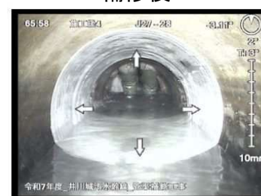
補修前後状況 井川城幹線(松本市より)
