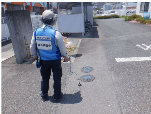
点検状況（長野市より）
