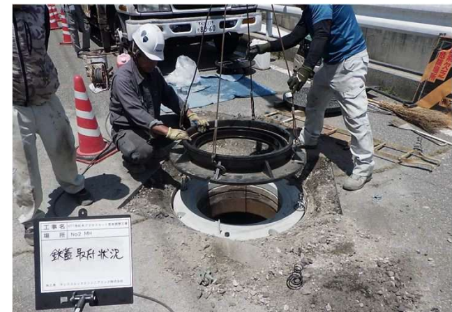
補修事例 松本市道（ソフトバンクより）
