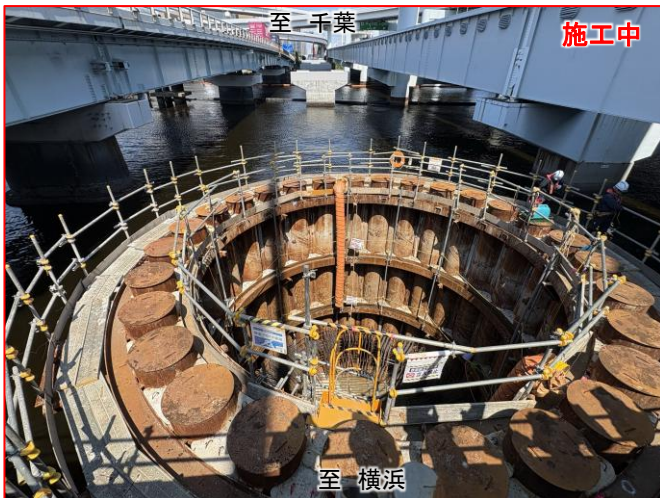
📷 ①:有明西運河部(橋梁下部工事) R8.8
