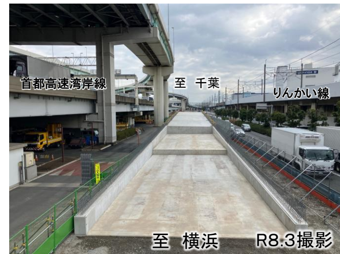
📷 ③:辰巳交差点部(擁壁工事) R8.3撮影
