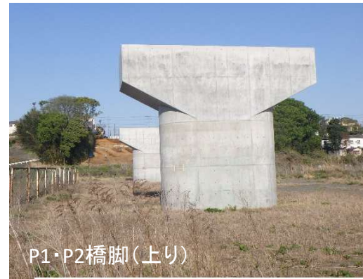
写真② 中津川橋 下部工事(R4.6完成)
