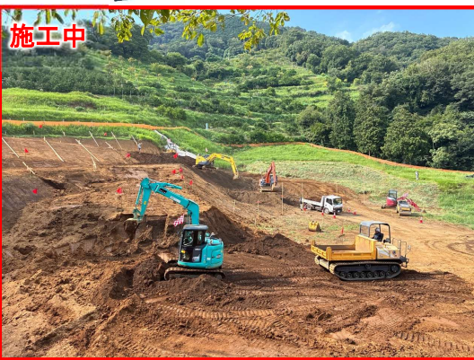
写真⑧ 伊勢原市善波/工事用進入路工事(R8.2)
