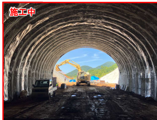
写真⑥ 伊勢原第一トンネル工事(R8.7)
