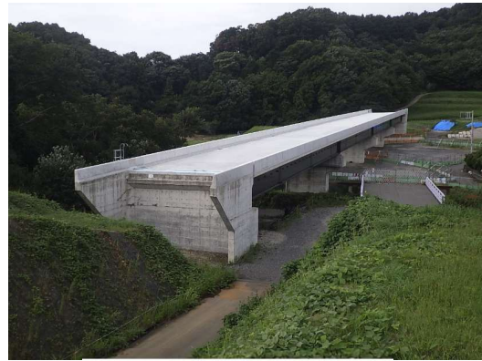
写真④ 鈴川橋(R4.9完成)
