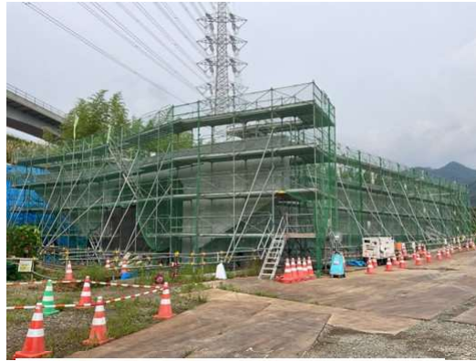
写真③ 上粕屋地区排水路工事(R8.6)
