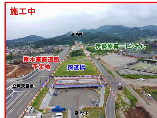
写真⑤ 跨道橋上部工事(R8.8)
