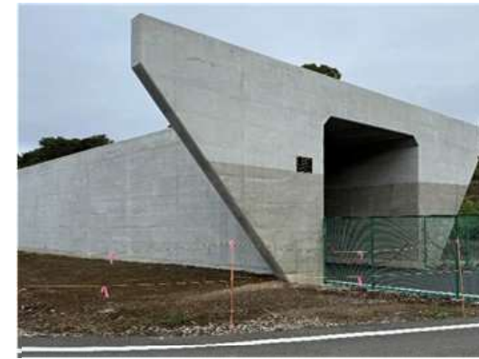
写真① 中依知地区函渠工事(R7.11完成)
