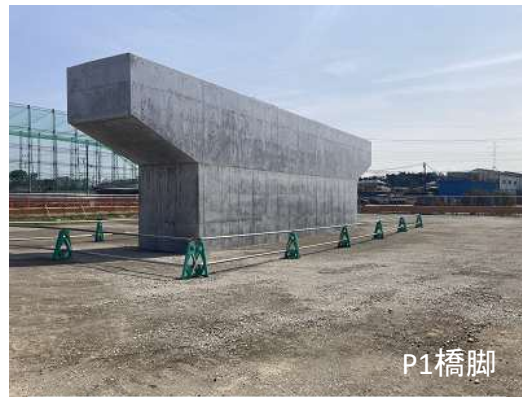
写真③ 厚木BP橋下部工事(R7.3完成)
