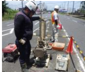
（貫入試験による調査）
