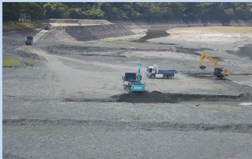
酒匂川上流部の三保ダムに堆積した土砂の掘削状況です。
