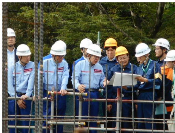
雨水貯留施設で説明を受ける金子大臣、永井政務官、上田政務官(千葉市弁天地区)
