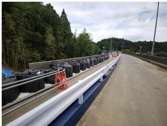
応急復旧完了状況(千葉市緑区)
