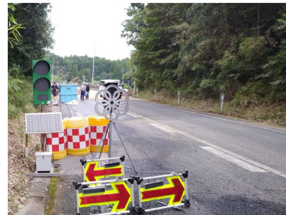
応急復旧完了状況(市原市)
