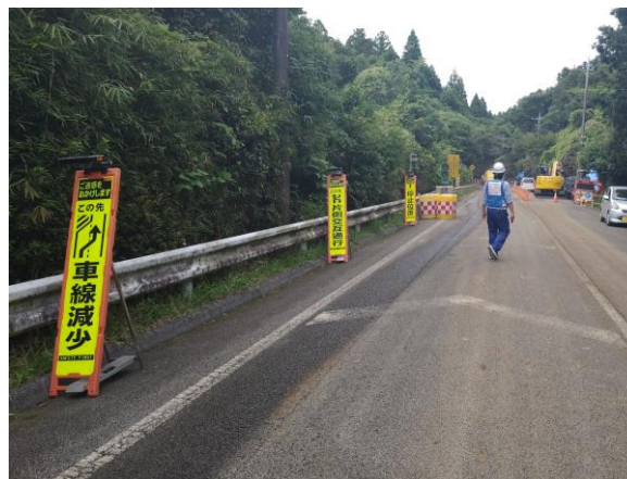
応急復旧完了状況(千葉市緑区)
