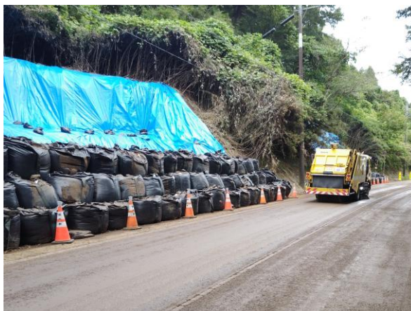
路面清掃状況
