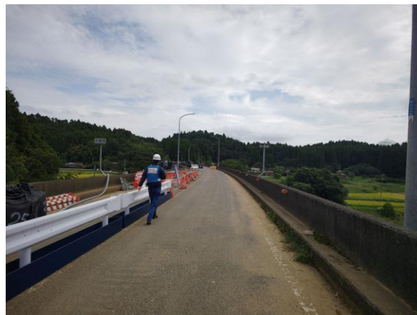
応急復旧完了状況(市原市)
