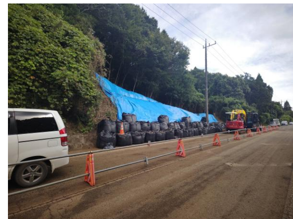
応急復旧完了状況(千葉市緑区)
