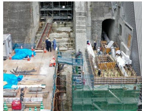
【小容量放流設備操作室(基礎工)】 （撮影日：R8.8.24）
