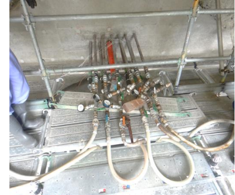
【放流設備工(グラウト充填)】 （撮影日：R8.8.19）
