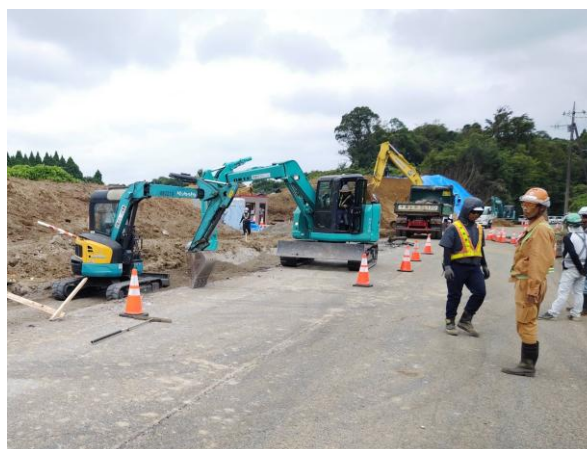
応急復旧作業状況(市原市)
