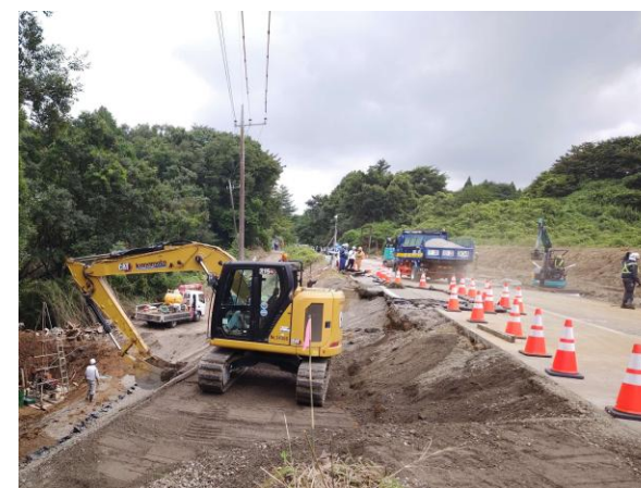
応急復旧作業状況(市原市)
