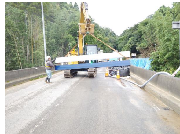
応急復旧作業状況(千葉市緑区)
