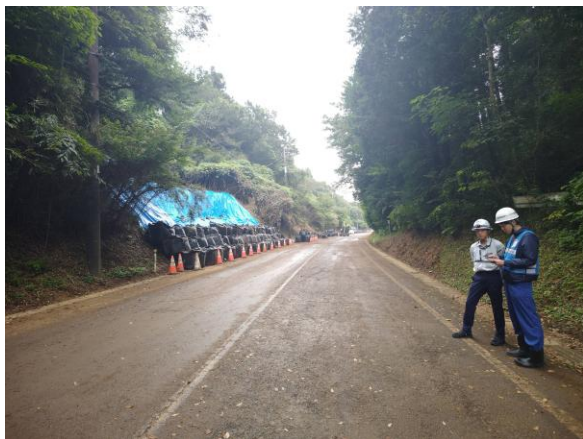
応急復旧作業状況(千葉市緑区)
