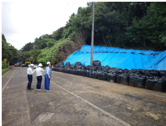
応急復旧作業状況(千葉市緑区)
