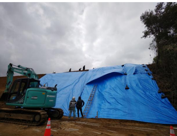
応急復旧作業状況(市原市)
