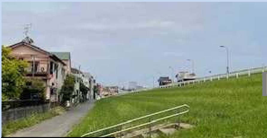
施工前 令和7年6月2日
