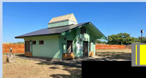
解体前 令和7年7月29日
