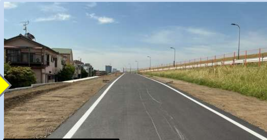
施工後 令和8年5月19日
