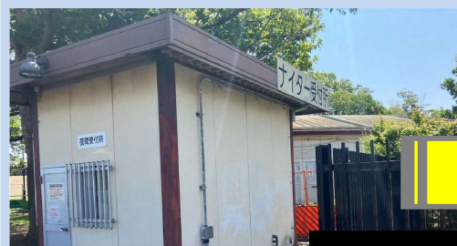
解体前 令和7年8月27日
