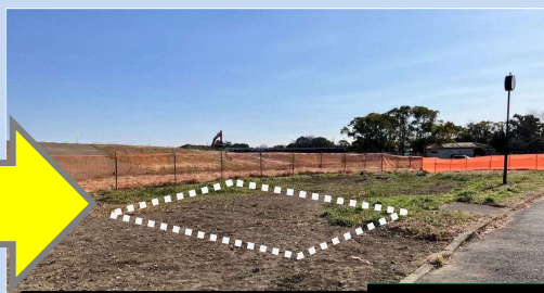
解体後 令和8年1月30日
