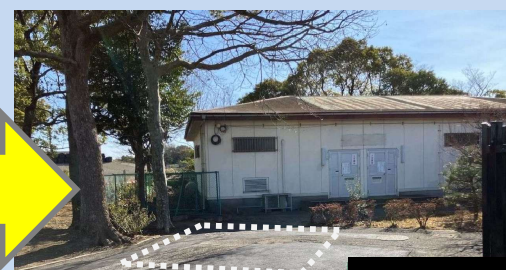
解体後 令和8年1月30日
