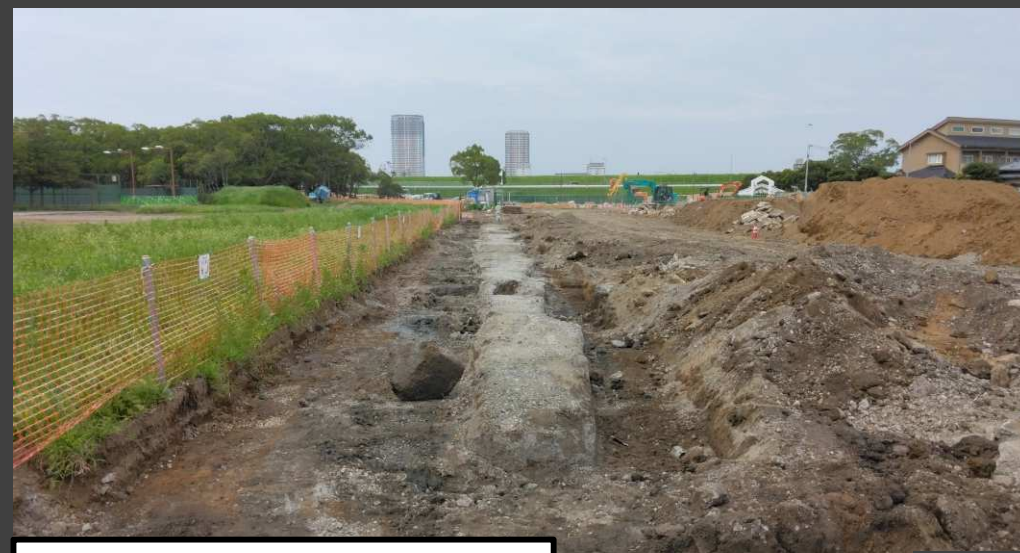
道路舗装・下水道撤去状況
