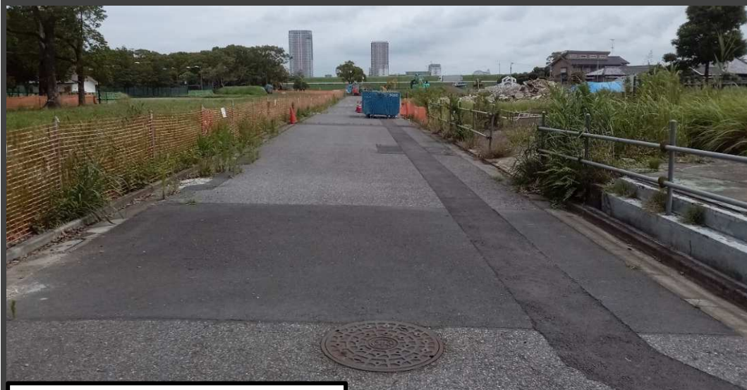
道路舗装・下水道撤去前
