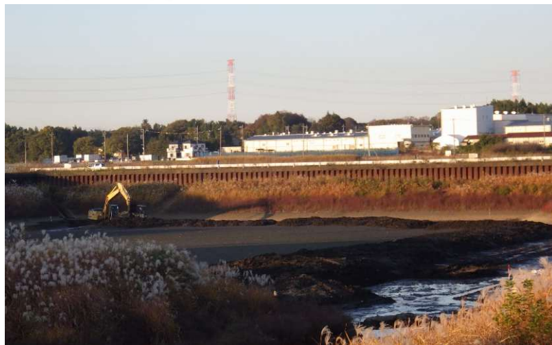
令和5年度実施北部第1調整池浚渫工事
