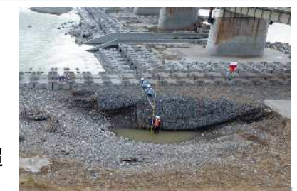
多摩川左岸35.0k（京王線多摩川橋梁） （府中市）
