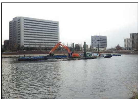
下流部の河道浚渫状況
