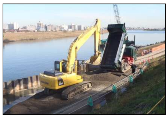
盛土材の搬入状況
