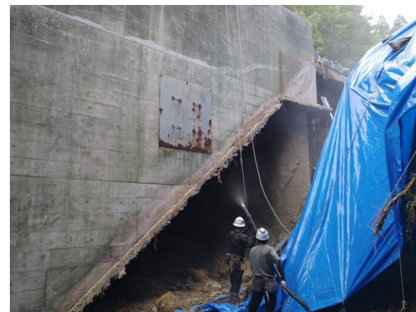
応急復旧作業状況(千葉市緑区)
