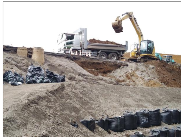
応急復旧作業状況(市原市)
