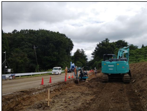
応急復旧作業状況(市原市)
