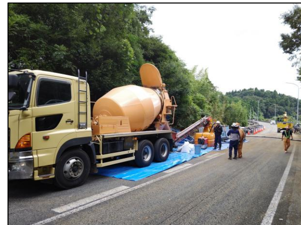
応急復旧作業状況(市原市)
