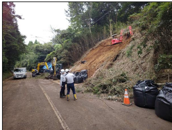
応急復旧作業状況(千葉市緑区)
