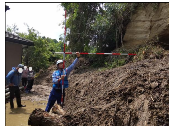
被災状況調査(大網白里市)
