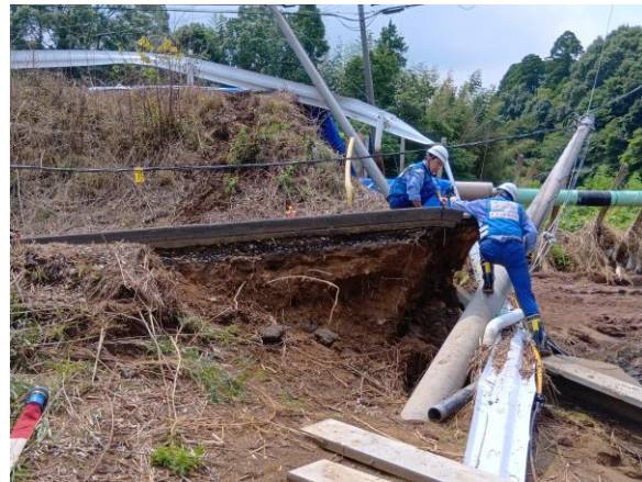
被災状況調査(八街市)
