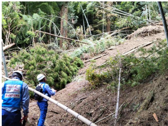
被災状況調査(大網白里市)
