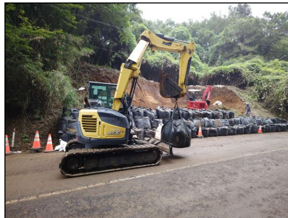
応急復旧作業状況(千葉市緑区)
