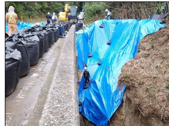
応急復旧作業状況(千葉市緑区)
