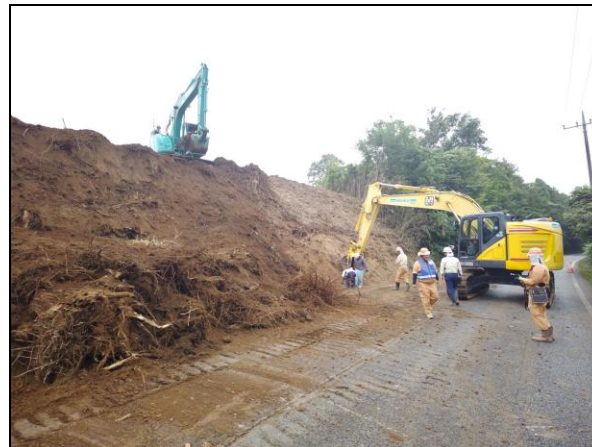
応急復旧作業状況(市原市)
