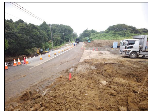
応急復旧作業状況(市原市)
