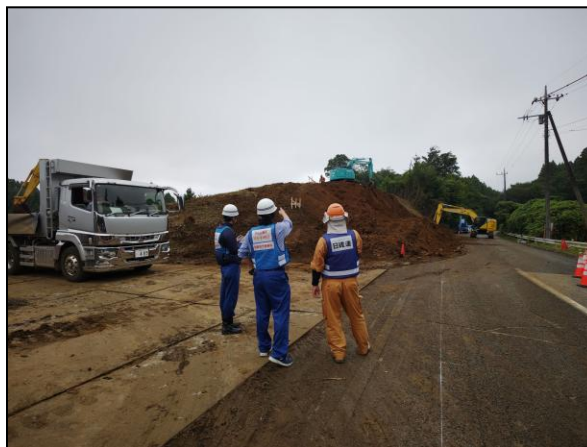
応急復旧作業についてTEC-FORCEパートナーと 現地打合せ(市原市)
