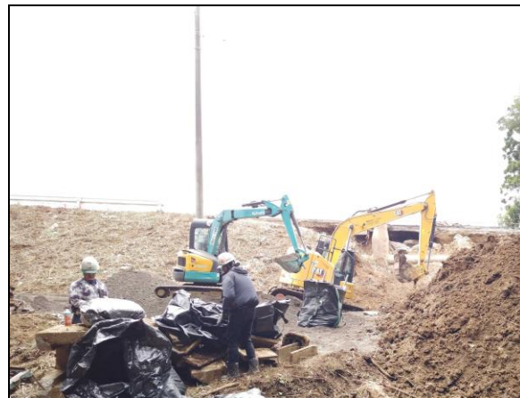
応急復旧作業状況(市原市瀬又)
