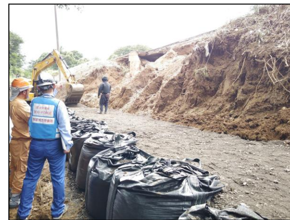
応急復旧作業状況(市原市瀬又)
