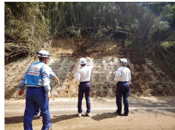
応急復旧支援に向けたTEC-FORCEパートナーと被災状況調査(千葉市緑区越智町)
