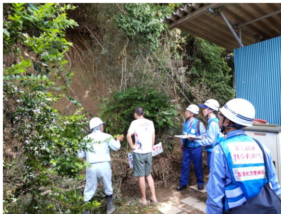
被災状況調査(大網白里市)
