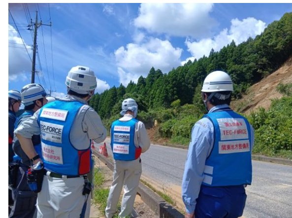
TECパートナーとの被災状況調査(市原市)
