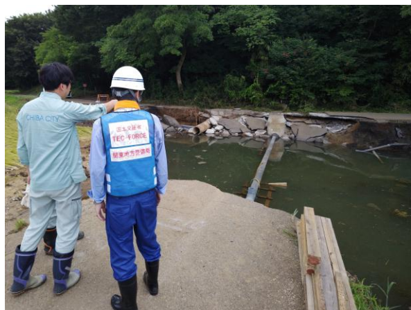
自治体との被災状況調査(千葉市)
