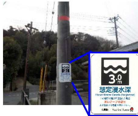
電柱(東電柱)の設置状況
