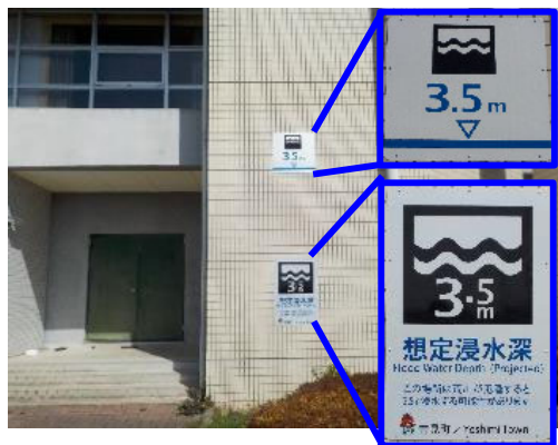
公共施設等壁面の設置状況
