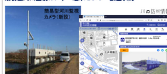
簡易型河川監視カメラ・越水センサー設置状況
