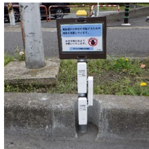
道路浸水センサ設置状況
