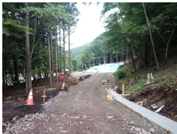
③ 撮影日：R8. 7. 30 ◆ No.48付近 排水構造物工基礎 施工状況
