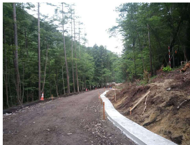
④ 撮影日：R8. 7. 30 ◆ No.43付近 排水構造物工基礎完了
