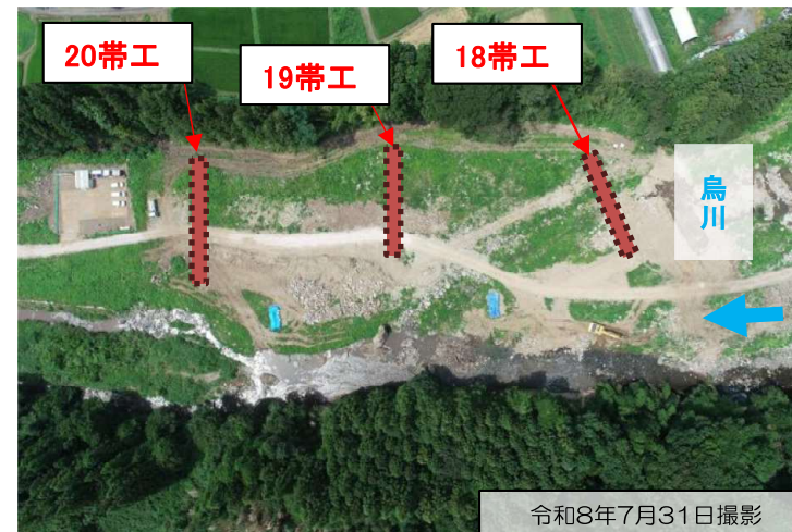
現場を上空から 仮設工
