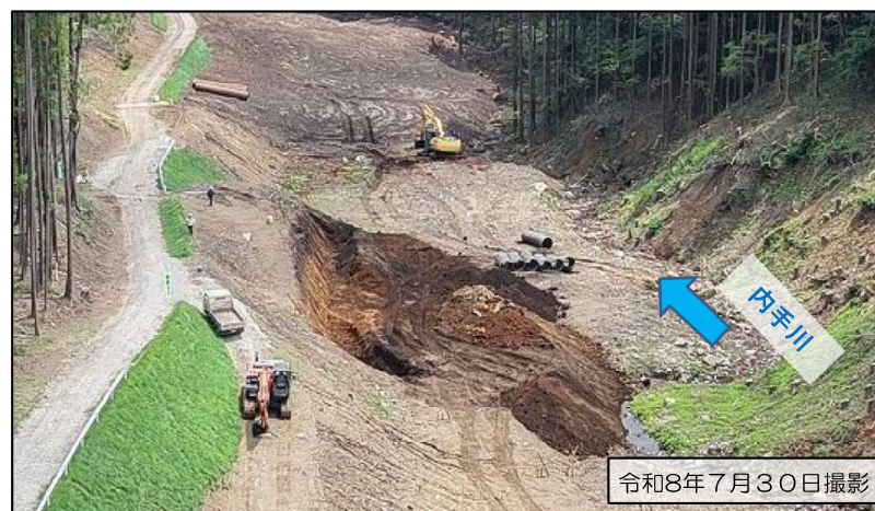
左岸側掘削作業中（空撮）
