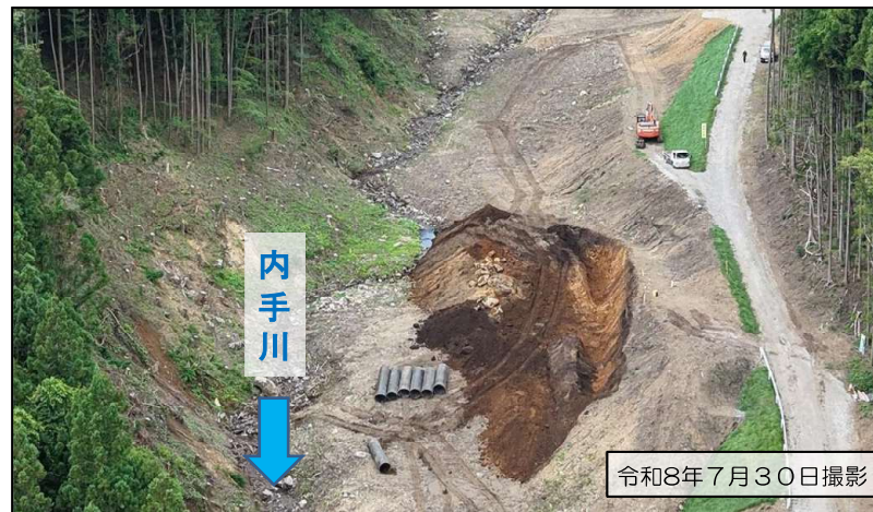
左岸側掘削作業中（空撮）
