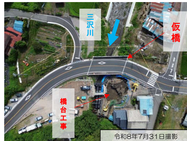
橋台工 施工状況
