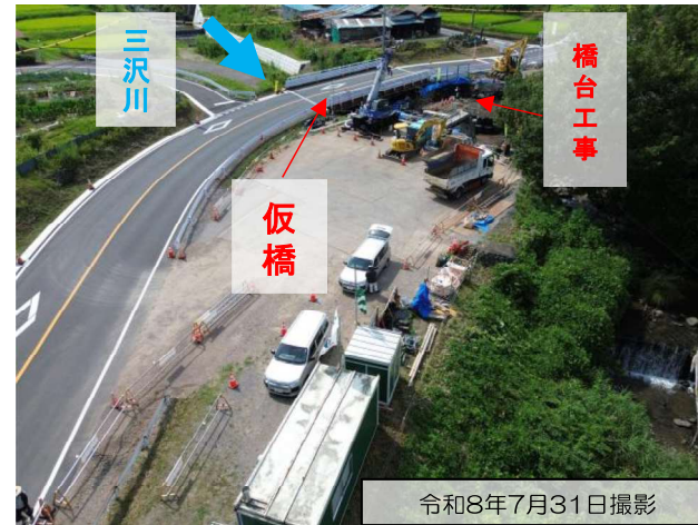
三沢橋を上空から
