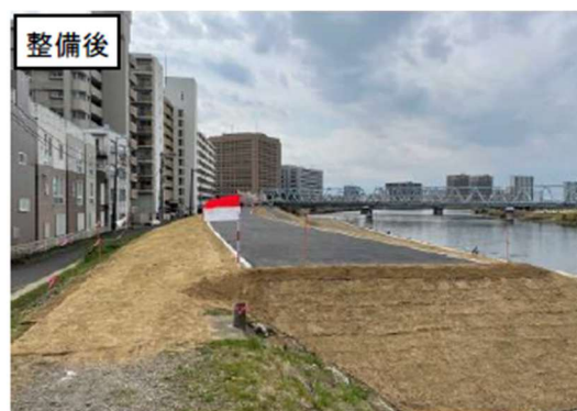
築堤整備後の多摩川の様子
