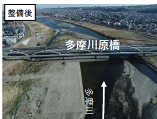
河道掘削後の多摩川の様子
