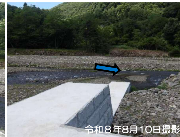
左岸部立木伐採状況(帯工)
