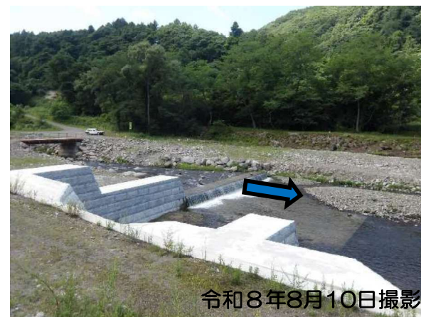
左岸部立木伐採状況(床固工)
