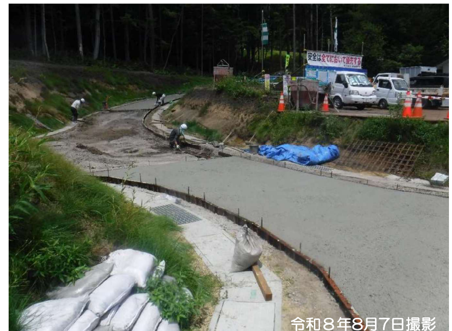
中原沢管理用道路 コンクリート舗装 施工状況
