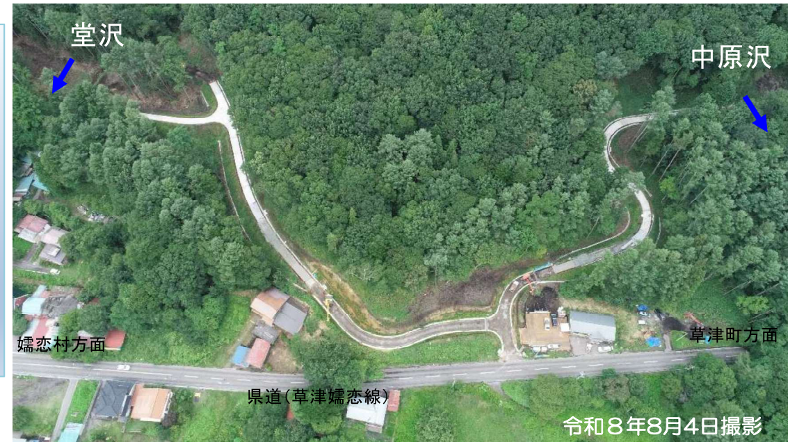
工事施工状況(全景) 管理用道路等のコンクリート舗装中
