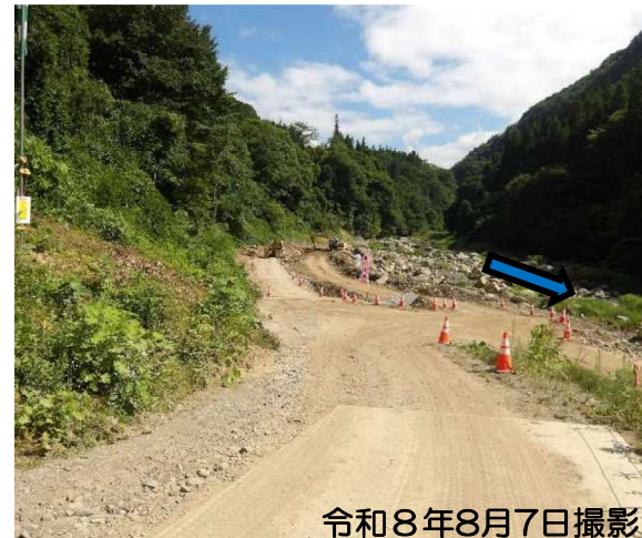
工事用道路(近景) 起点から終点方向を望む
