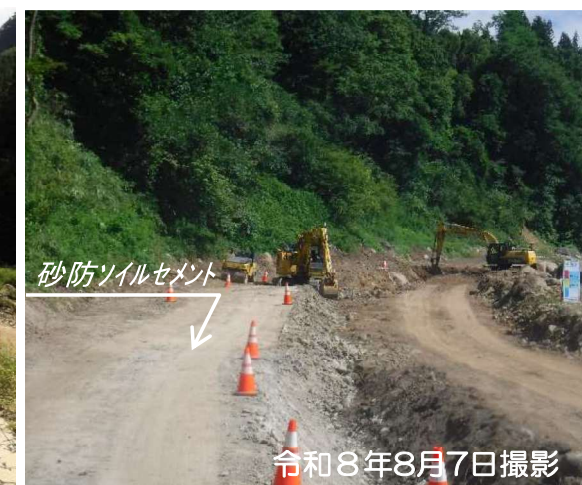
工事用道路(近景) 盛土工(砂防ソイルセメント)敷均し・転圧状況
