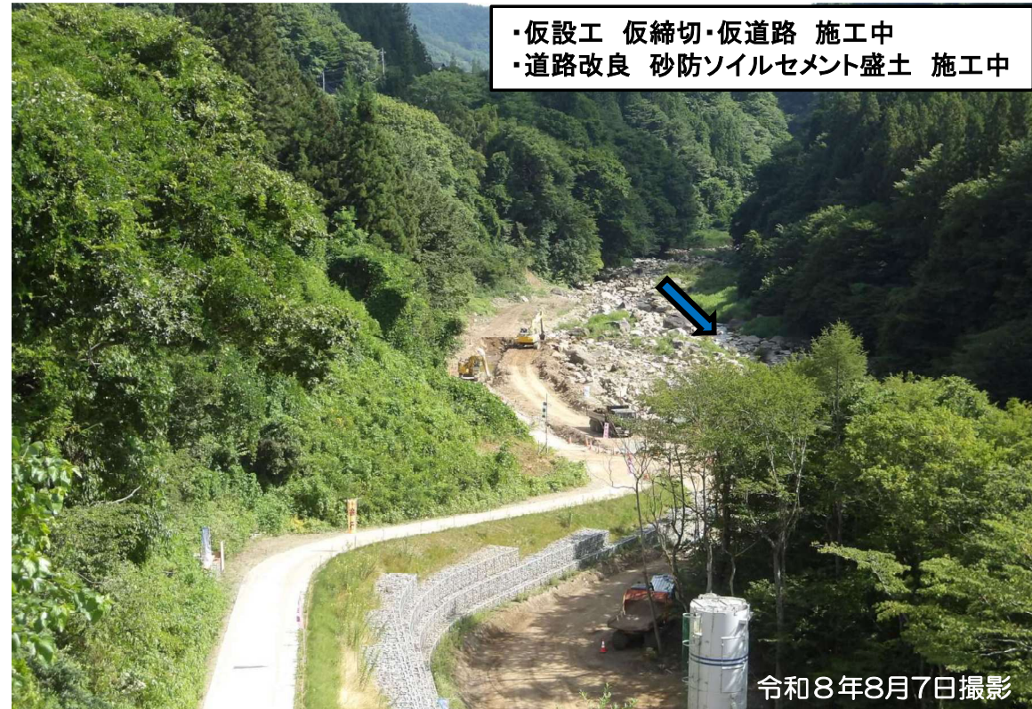
工事用道路(全景)
