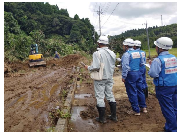
市原市内の被災状況調査
