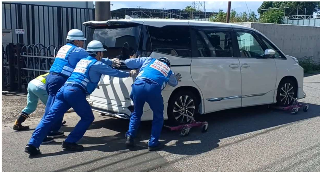
道路啓開作業（ゴージャッキによる車両の移動）③
