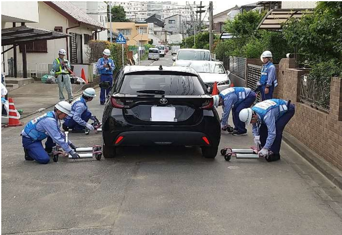
道路啓開作業（ゴージャッキによる車両の移動）①
