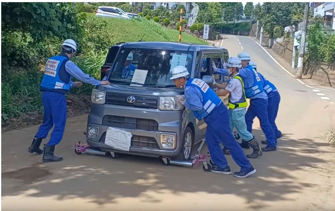
道路啓開作業（ゴージャッキによる車両の移動）②
