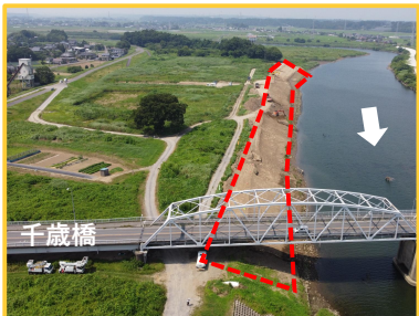
工事箇所の全景（下流から）
