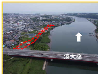
工事箇所の全景（上流から）
