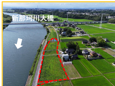
工事箇所の全景（上流側）
