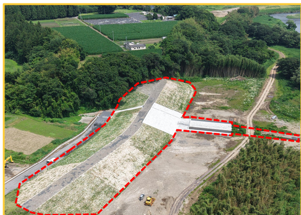
上流側から施工箇所を望む
