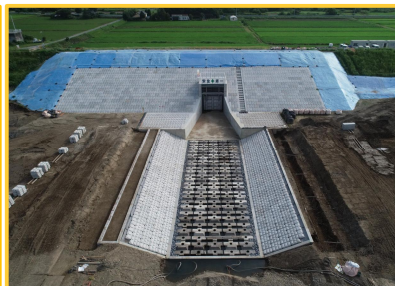
護岸ブロック設置
