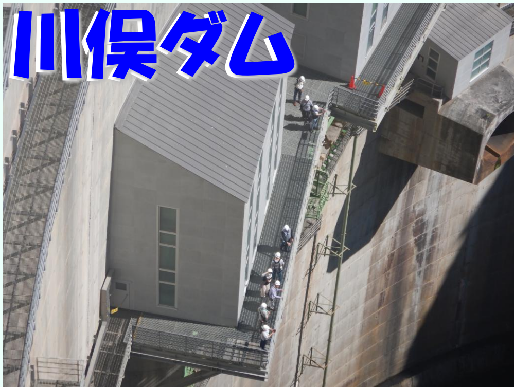
点検通路(キャットウォーク)を歩く
