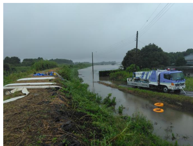
茂原市内での排水活動状況
