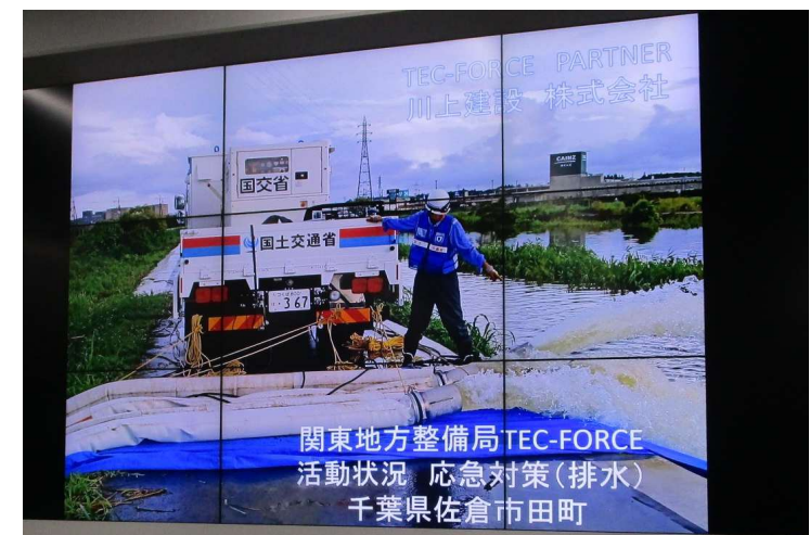
既に現地で行われている対応状況
