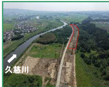
工事箇所の全景（上流から）
