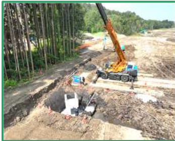
集水枡を設置しています
