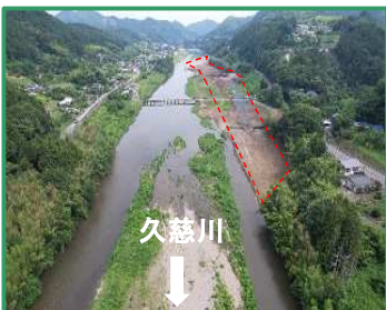
工事箇所の全景（下流から）
