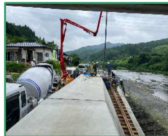
擁壁工のコンクリートを打設しています
