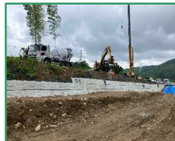
ブロック積を行っています
