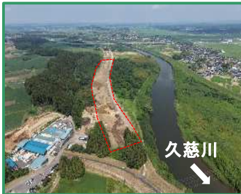
工事箇所の全景（下流から）
