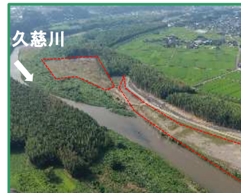
工事箇所の上流全景（右岸から）
