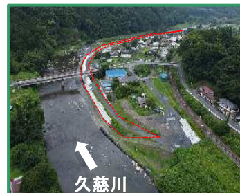
工事箇所の全景（上流から）
