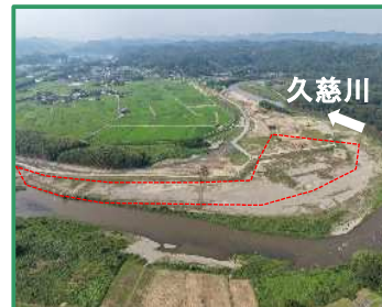
工事箇所の下流全景（右岸から）
