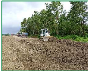
工事用道路の整備を行っています
