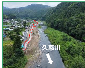
工事箇所の全景（下流から）
