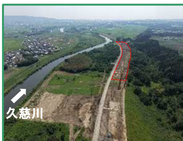
工事箇所の全景（上流から）
