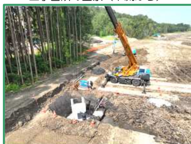
集水枘を設置しています
