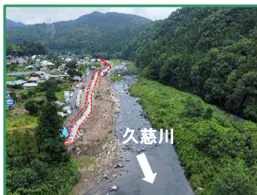
工事箇所の全景（下流から）
