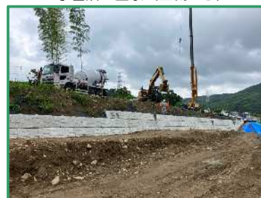
ブロック積を行っています
