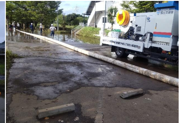
四街道市における排水活動の様子 (利根川下流河川事務所)
