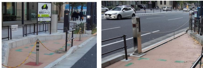
図 35 ライジングボラード、チェーンゲートの設置例
