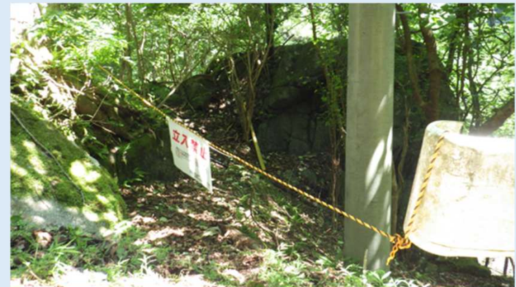
対策後 立入禁止看板及びロープ設置した
