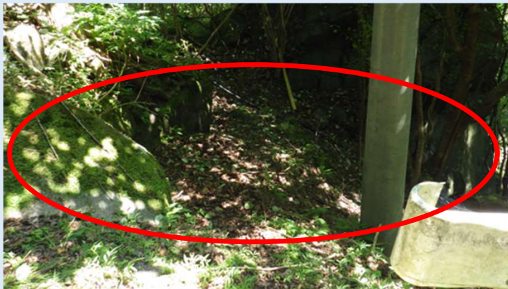
対策前 堰堤下流より高所へのアクセスが可能となっている
